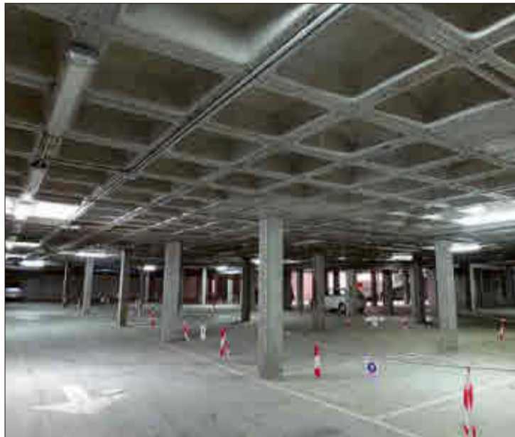
El aparcamiento subterráneo que está debajo de Es Fossaret. J. MORA
