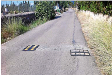
Vista general del camino 140, donde se puede apreciar el mal estado de los badenes para reducir la velocidad de los vehículos.
