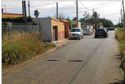
Vista general del camino 140, donde se puede apreciar el mal estado de los badenes para reducir la velocidad de los vehículos.
